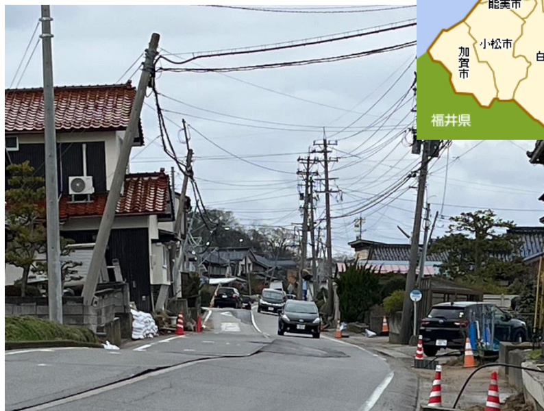
内灘町の液状化被災
